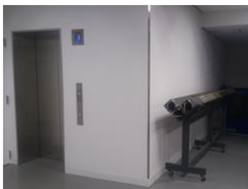
写真1 新設エレベータ (右に見えるのは燃料棒模型)
