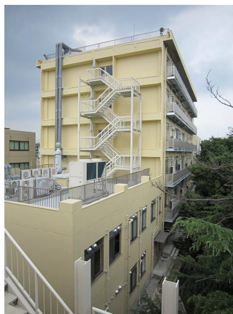
耐震改修を終えた 8 号館南棟 外観（9 号館屋上より）
