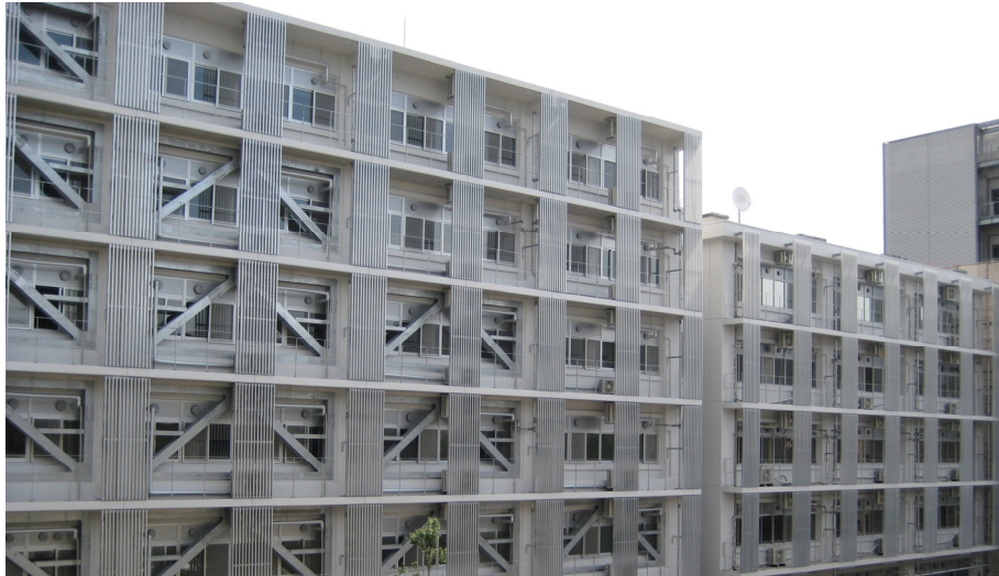
図1. 耐震改修を終えた5号館東側（量子エネルギー工学教室入居部分）外観
